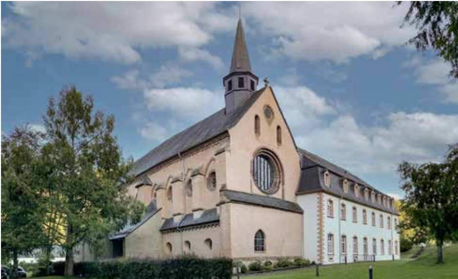
Abb. 4: Zu Ehren des 1170 ermordeten und 1173 heiliggesprochenen Erzbischofs von Canterbury, Thomas Becket, wird im Kylltal um 1185 ein Zisterzienserinnenkloster (das älteste in Deutschland) gegründet. Der älteste Bauteil der Klosterkirche wurde 1222 geweiht. Ein Brand im Jahr 1742 zerstörte die gesamte Abtei, nur die Kirche blieb erhalten. Der Klosterbau wurde im Jahr 1744 im Barockstil neu aufgebaut. Im Jahr 1802 wurden die Nonnen durch die Säkularisation aus dem Kloster vertrieben. Heute wird das Kloster als bischöfliches Priesterhaus und Bildungsstätte genutzt.
